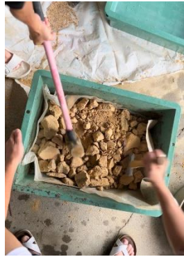
↑土壁を砕く様子
