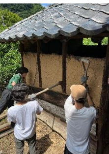
↑壁解体の様子
