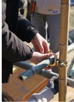
↑単管ジョイントを用いて固定
